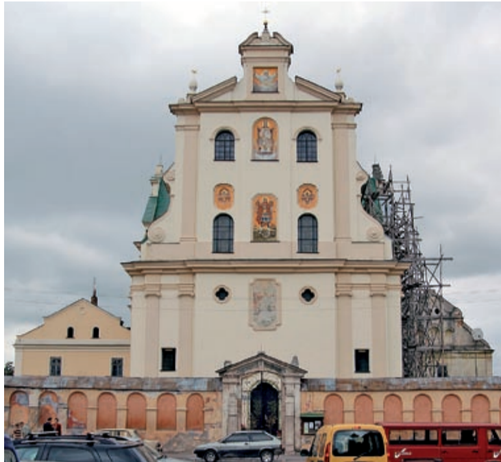
Fasada główna kościoła poddominikańskiego w trakcie odnawiania
