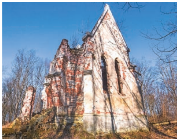
Obecny stan kaplicy Skarbków
