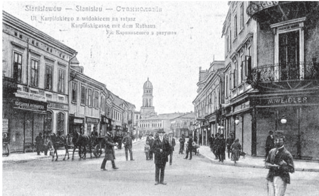
Pomiędzy budynkami po lewej była fosa z bramą
