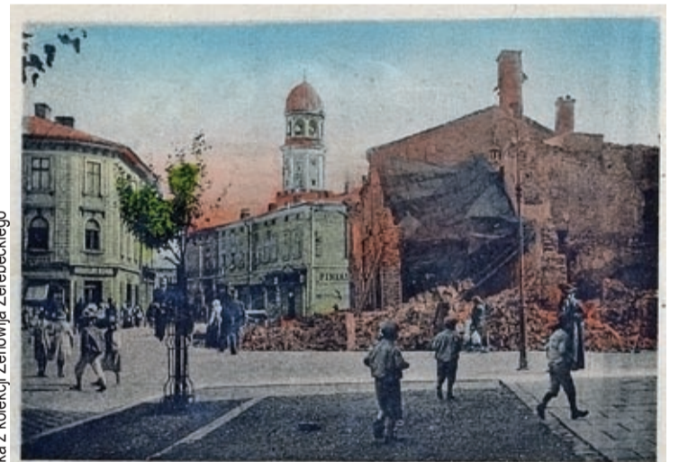
STANISLAU. Ruine Karpinskigasse. STANISLAU. Ruiny ul. Karpinskigo.
