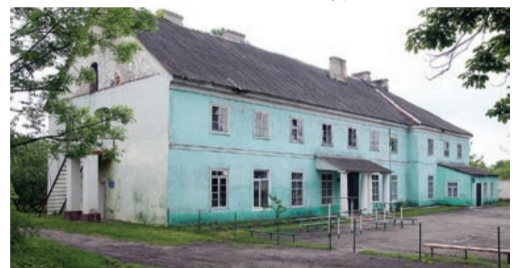
Zachowana część pałacu Franciszka Ksawerego Branickiego w Lubomlu
