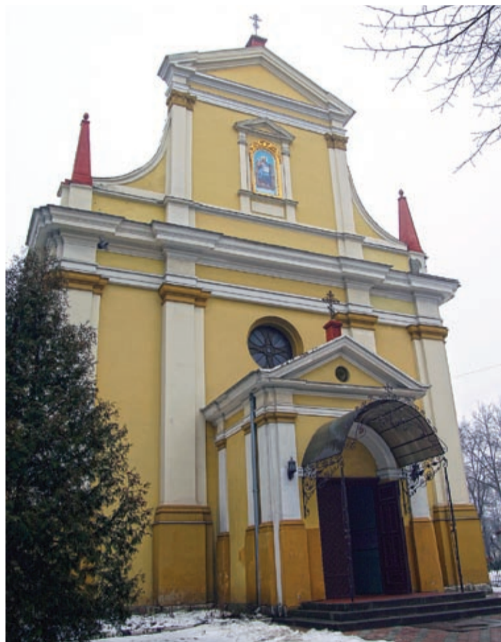
Elewacja pojezuickiego kościoła w Stanisławowie przed uszkodzeniem w 2018 roku
