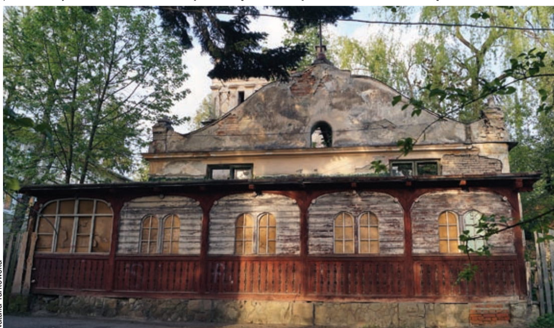
Stan sprzed rozbiórki, 2016 rok
