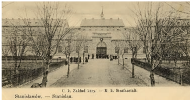
Więzienie „Dąbrowa” było pierwszą w mieście budowlą z kanalizacją i wodociągiem
