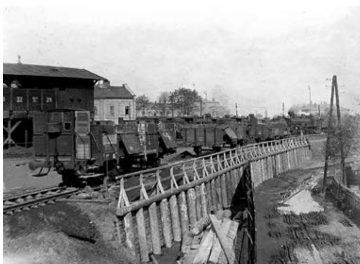
WIDOK NA TORY OD STRONY UL. DEPOWSKIEJ
