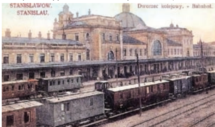
Dworzec kolejowy w Stanisławowie
